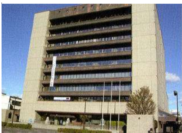
静岡市役所清水庁舎全景
